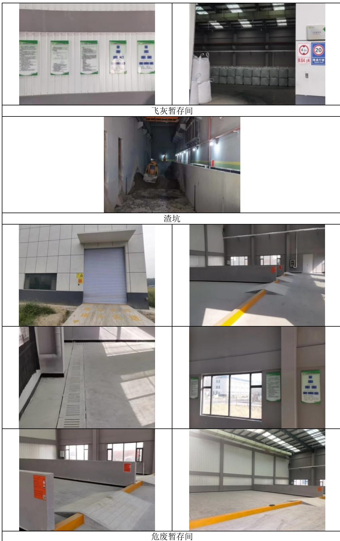
图 5-6 本项目固体废物治理及暂存设施实际建设情况
