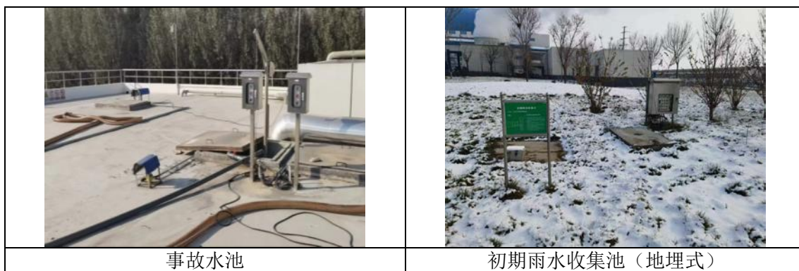
图 5-3 本项目废水治理设施实际建设情况
