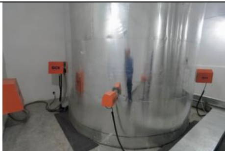
4#炉废气监测采样平台
