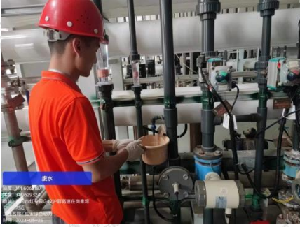
★废水采样点 - 渗滤液处理产水
