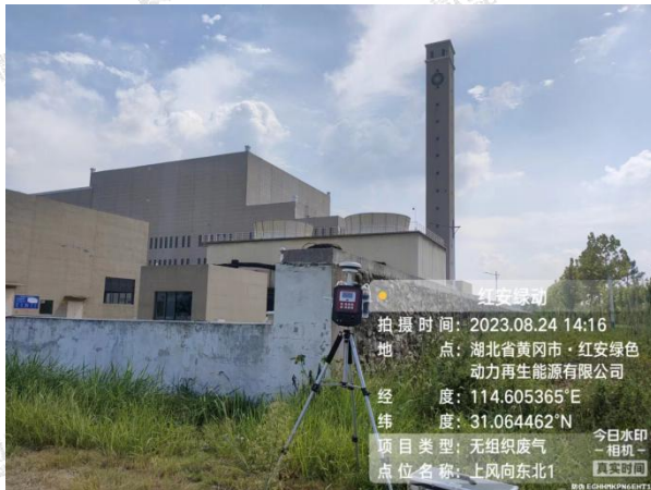
○废气(无组织)采样点 - 厂界上风向 1#
