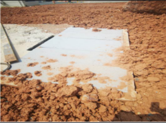
初期雨水收集池
