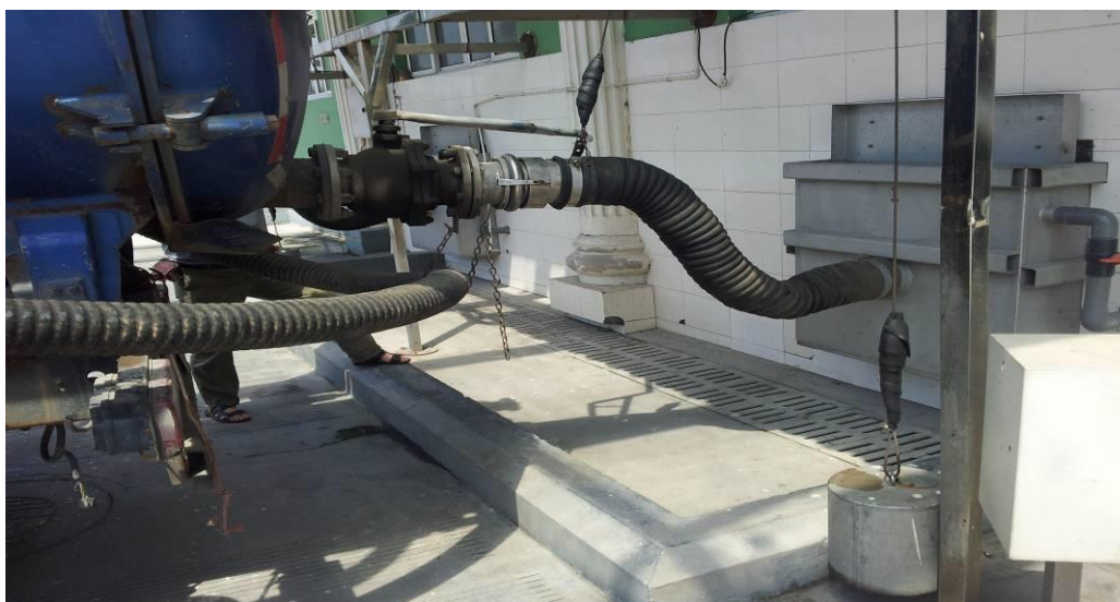
图 3.1-11 卸粪系统快速对接卸粪装置示意图
