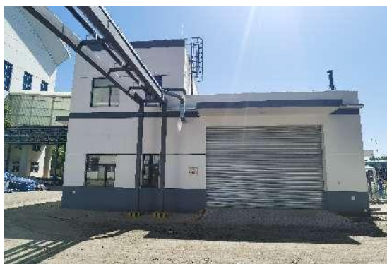
新增污水预处理站
