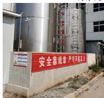
氨水罐区围堰
