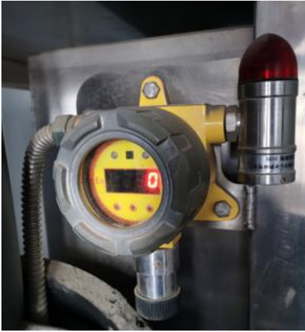
氨水罐区报警装置
