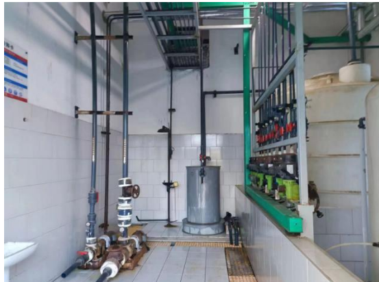
原有工程酸碱存放间
