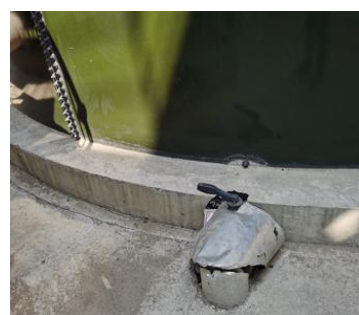
污水管道手动截止阀
