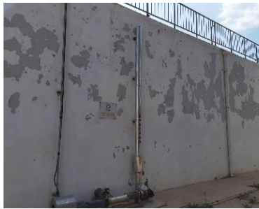
一期事故水池
