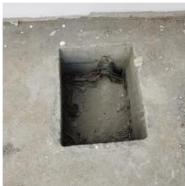
围堰内收集槽
