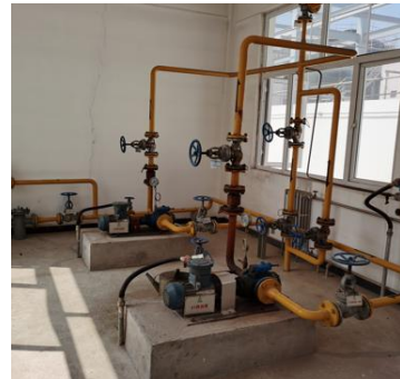
泵房内手动阀、逆止阀
