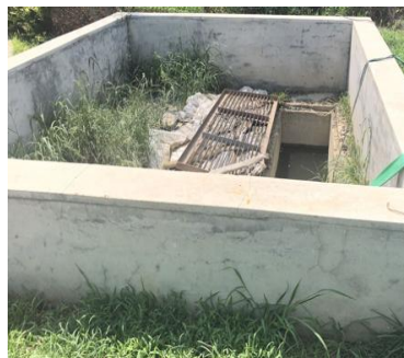
雨水收集暂存池
