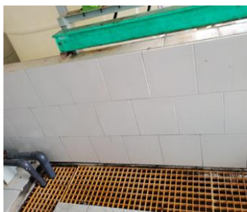
储罐间收集槽
