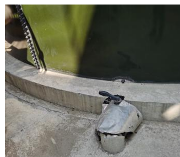
污水管道手动截止阀
