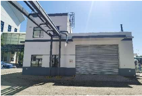
新增污水预处理站
