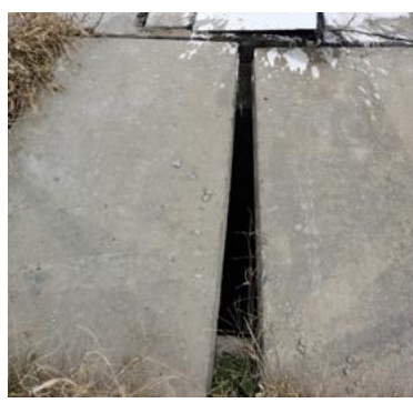
围堰外收集池
