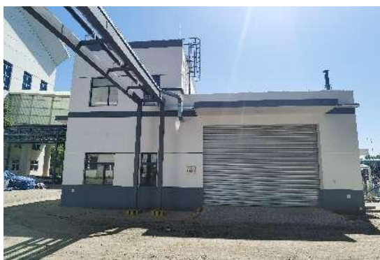
新增污水预处理站
