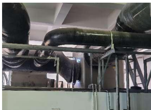
配套臭气收集管道和风机
