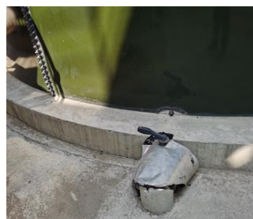
污水管道手动截止阀
