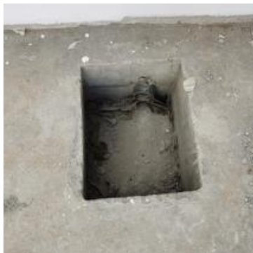
围堰内收集槽
