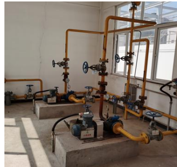
泵房内手动阀、逆止阀
