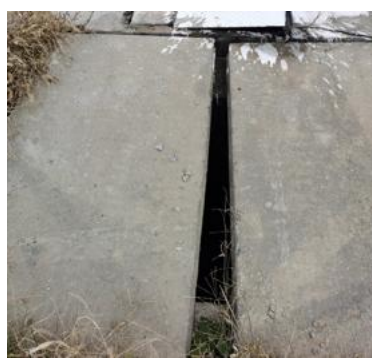
围堰外收集池
