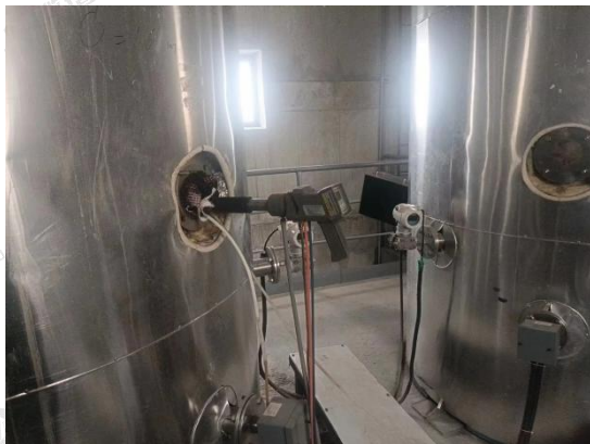
◎有组织废气采样点 - 1#废气排放口
